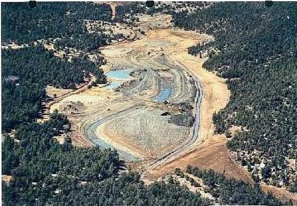
**Установка синтетического покрытия на подготовленной поверхности перед проведением каменной наброски/отсыпи**
